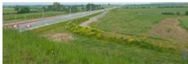
Des nouvelles infrastructures qui créent des ruptures dans le paysage, ligne LGV à Auvers-Le-Hamon
