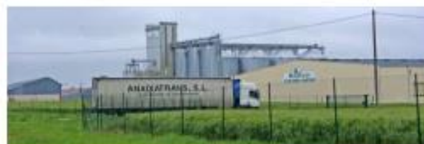
Des témoignages d'une industrie agroalimentaire active : le silo de Cossé-Le-Vivier
