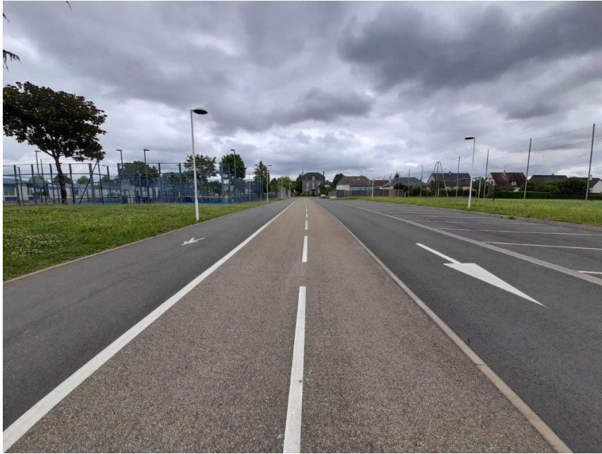
Bonchamp Lès Laval – rue des Sports : rue à sens unique avec voie piétonne et voie cyclable bidirectionnelle
